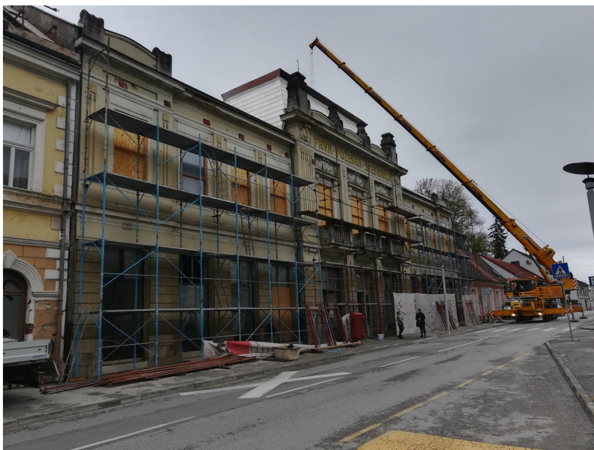
Fotografija snimljena 11. studenoga 2019., na Dan hrvatskih knjižnica. Dizalica podiže elemente za sustav grijanja u tornjeve na krovu zgrade Knjižnice.
